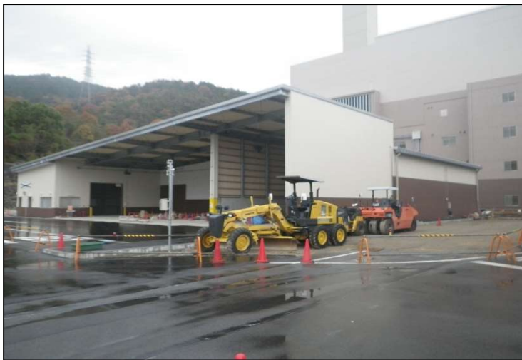
ストックヤード棟廻りの施工状況(南面)
