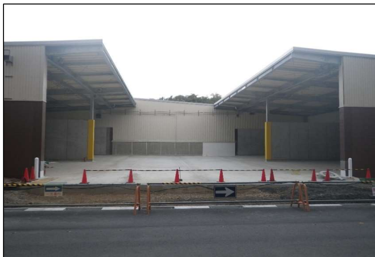
ストックヤードの施工状況(東面)
