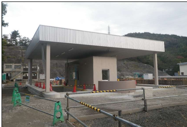
計量棟の施工状況(南面)
