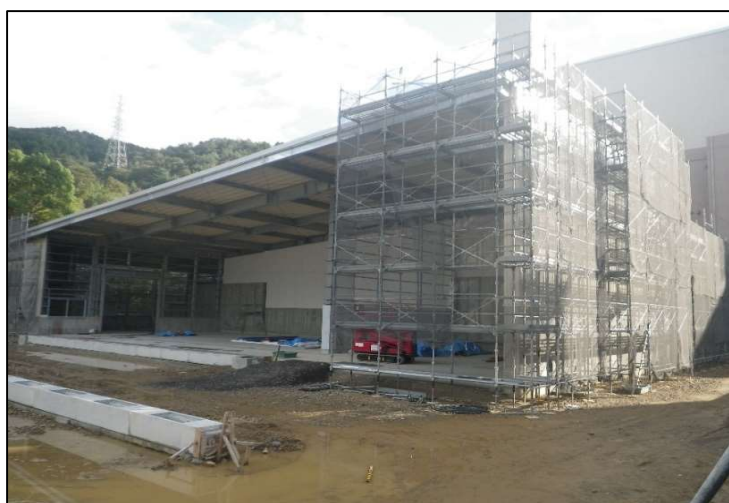
ストックヤードの施工状況
