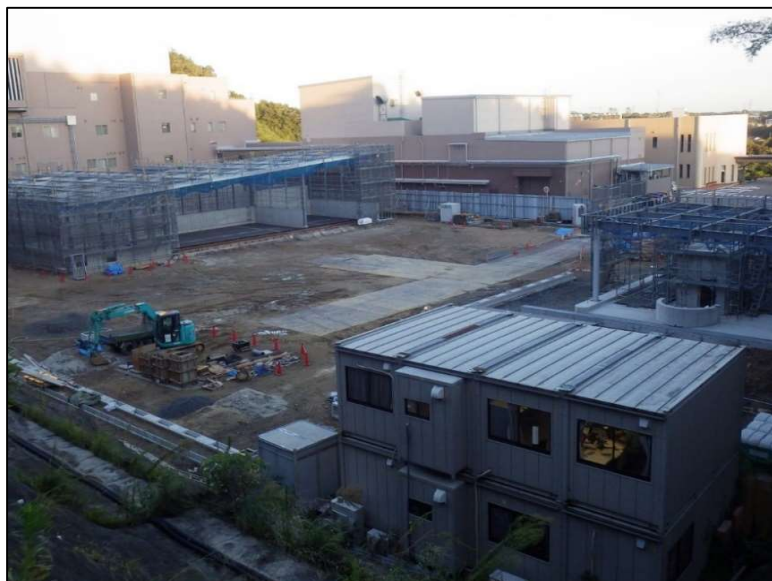
北西角からの全景
