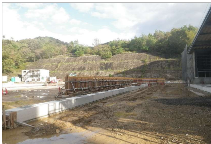
外構工事の施工状況
