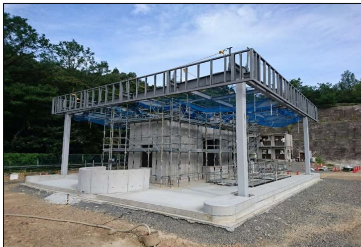
計量棟 鉄骨工事完了状況
