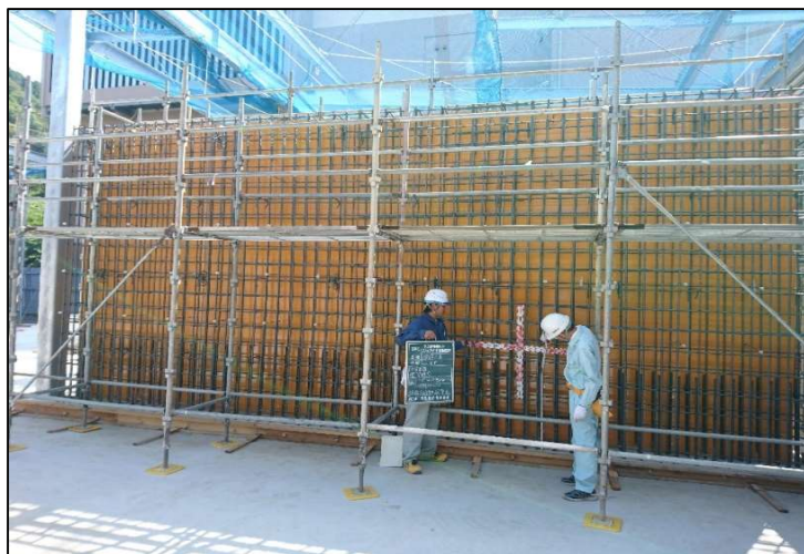
ストックヤードのコンクリート壁の施工状況
