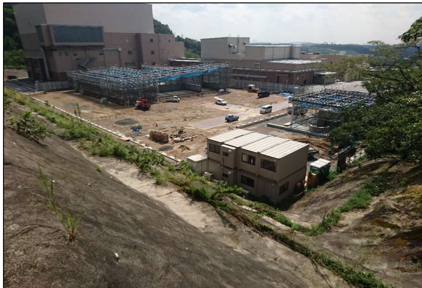
北西角からの全景
