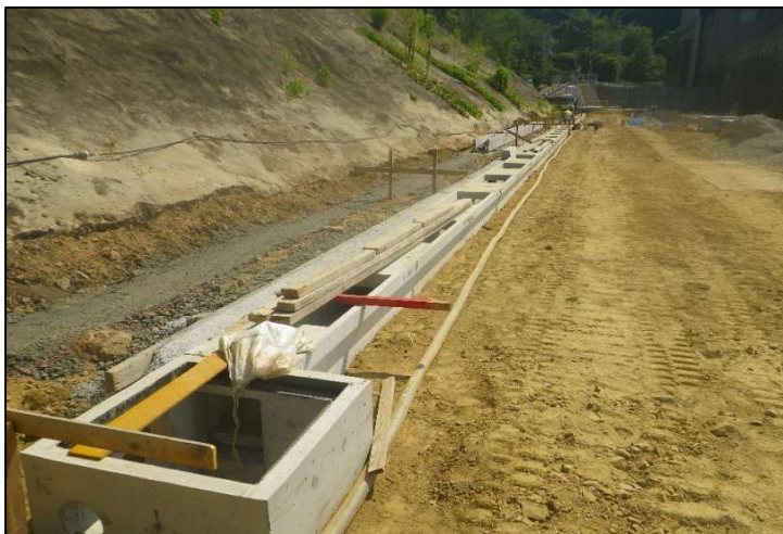
雨水排水工事状況
