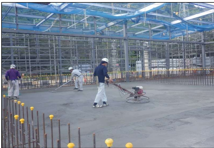
ストックヤードの土間コンクリート打設状況
