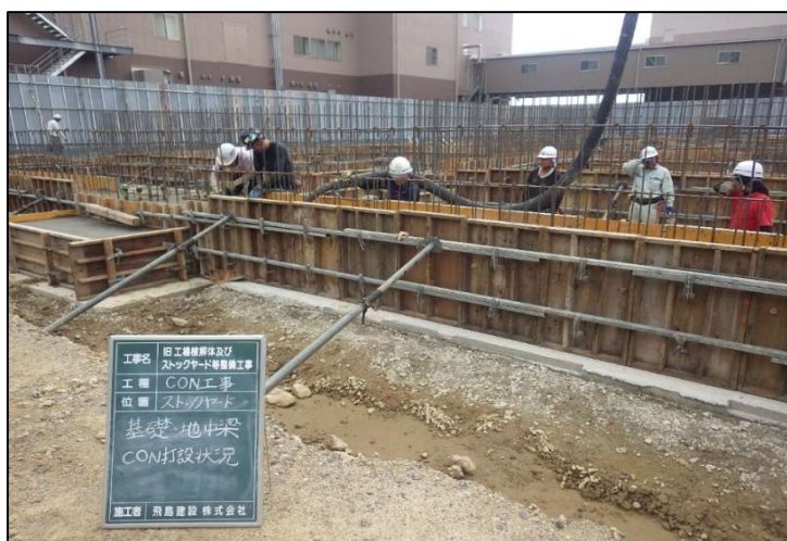
ストックヤードの基礎コンクリート打設状況
