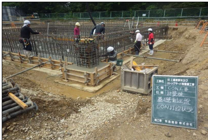
計量棟の基礎コンクリート打設状況
