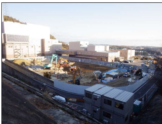
解体作業状況(北西角より)
