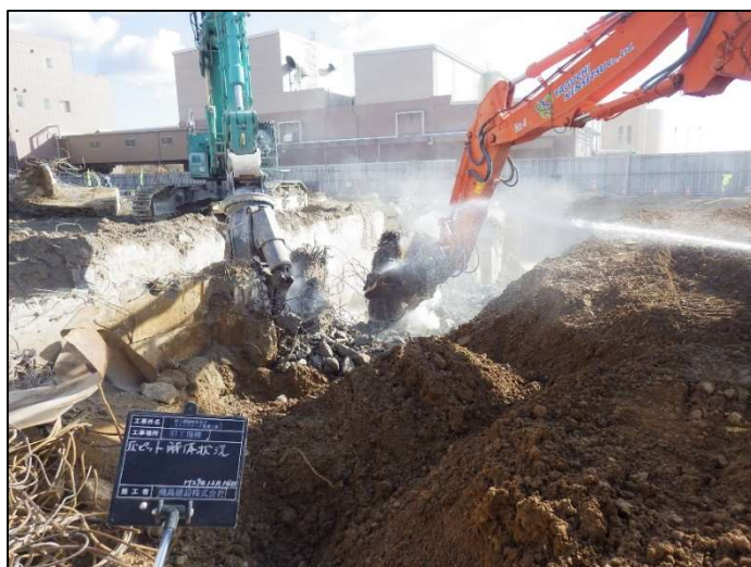
基礎解体作業状況
