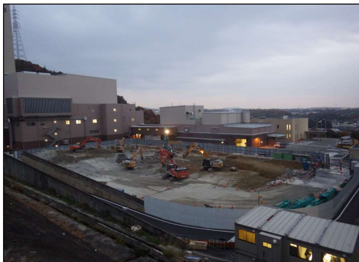
解体作業状況(北西角より)
