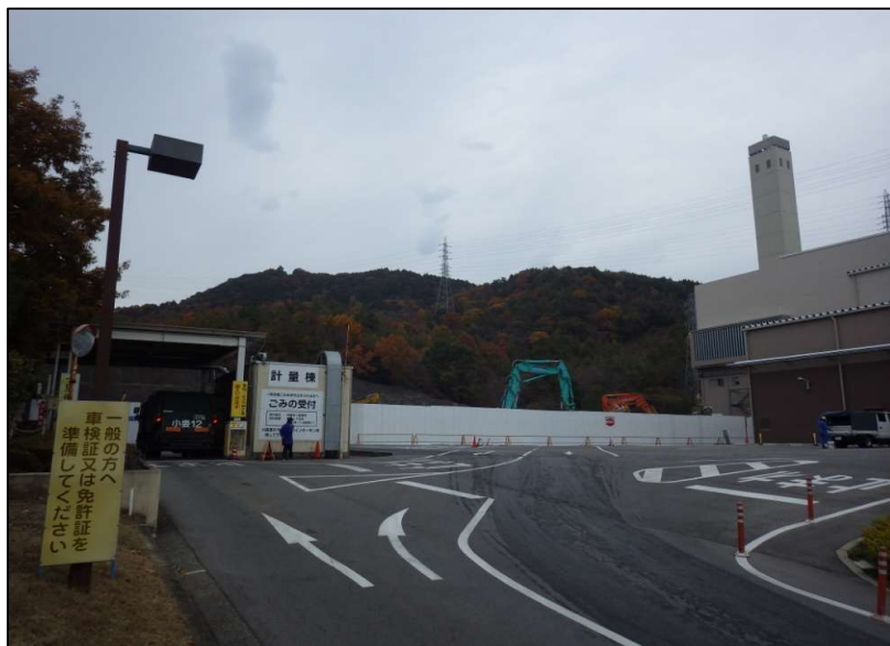
南面の作業状況
