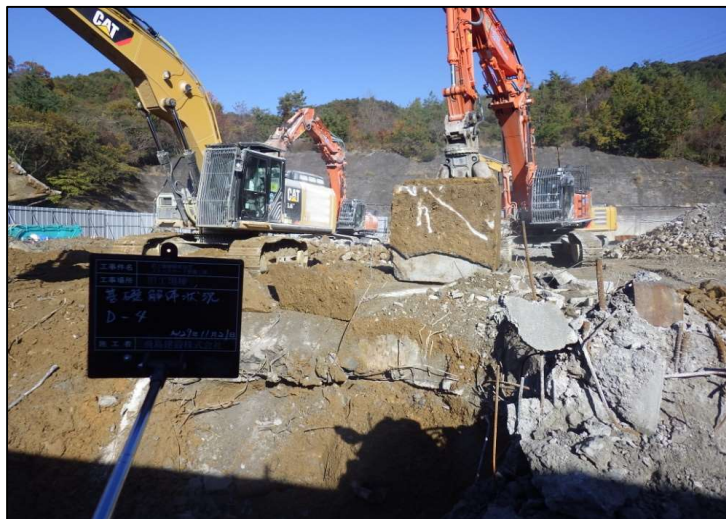
基礎解体作業状況
