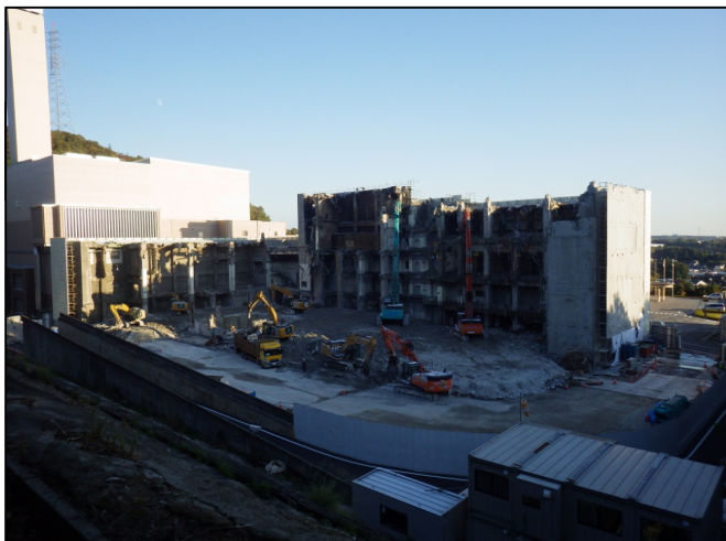
解体作業状況(北西角より)
