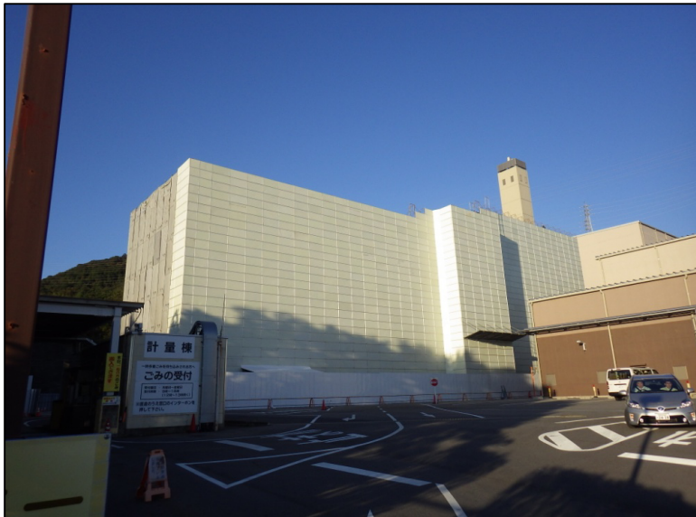
南面の作業状況
