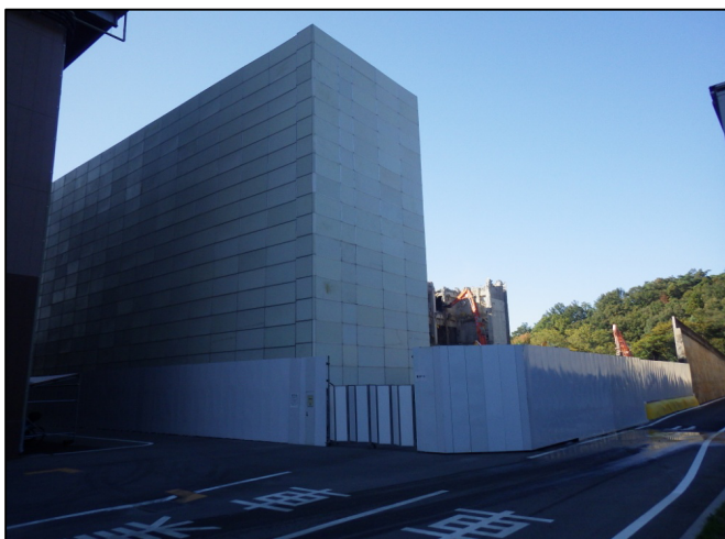
解体作業状況(北東角より)
