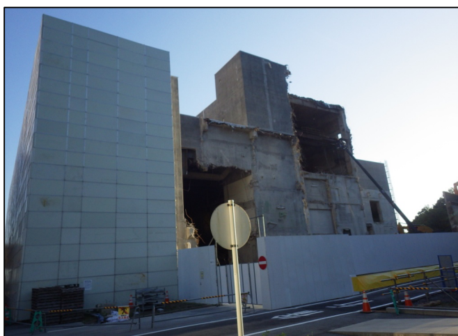
解体作業状況(北東角より)
