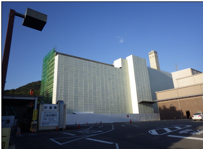
南面の作業状況
