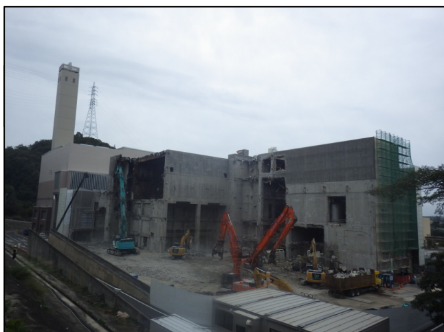
解体作業状況(北西角より)
