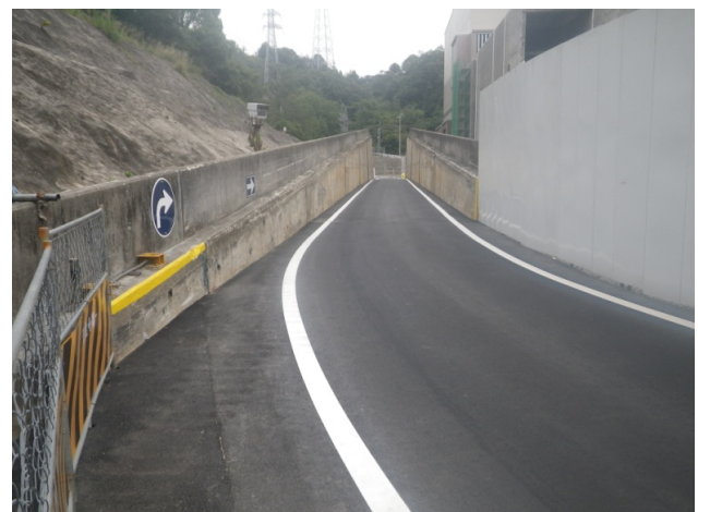
切り替え後構内道路の状況(旧工場棟の北側)
