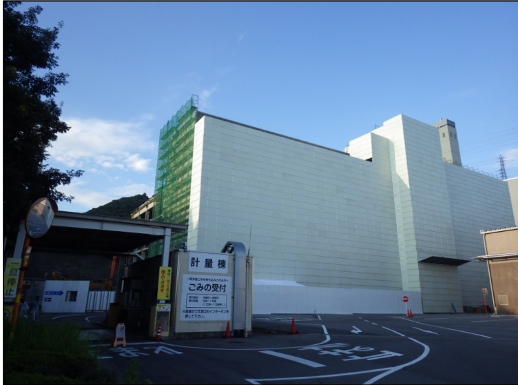
南面の作業状況
