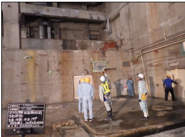
ごみ焼却設備の解体撤去完了確認状況
