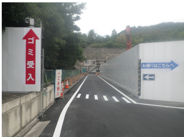
切り替え後構内道路の状況(旧工場棟の西側)
