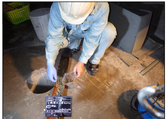
旧工場棟床下の土壌試験の資料採取状況
