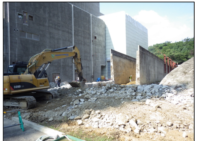
旧工場棟北側のランプウェイ解体状況
