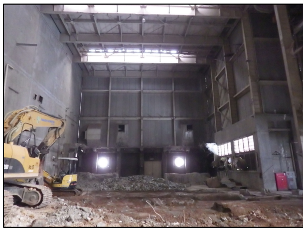
焼却設備の解体状況
