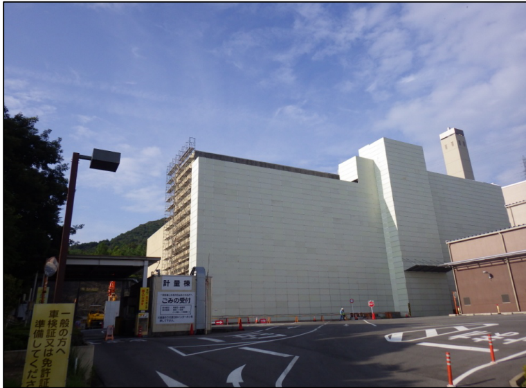
南面の作業状況
