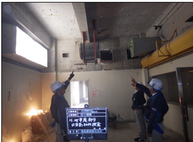
旧工場棟内装解体完了
