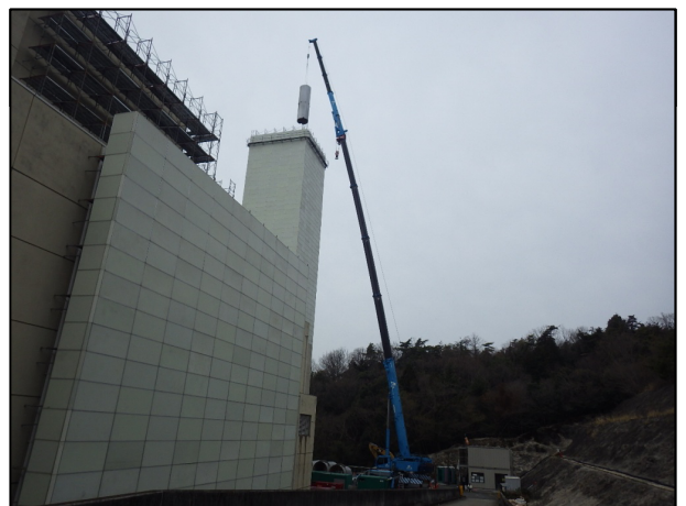
大型クレーンを使用しての内筒鋼管の撤去状況
