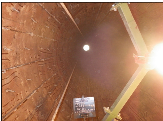
煙突内筒の耐火材撤去完了(下からの見上げ)
