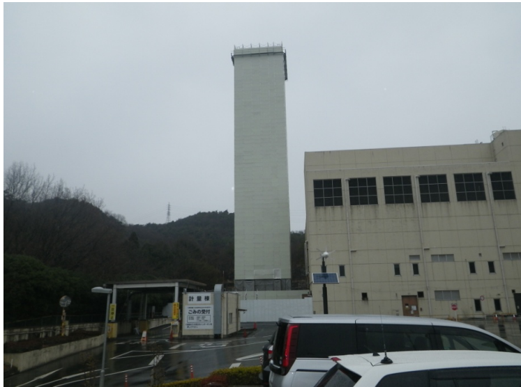
煙突内筒撤去完了(平成29年3月31日 撮影)
